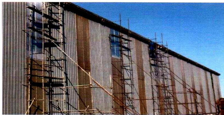
درزبندی، نصب فن در سوله ماشین آلات و انبار
