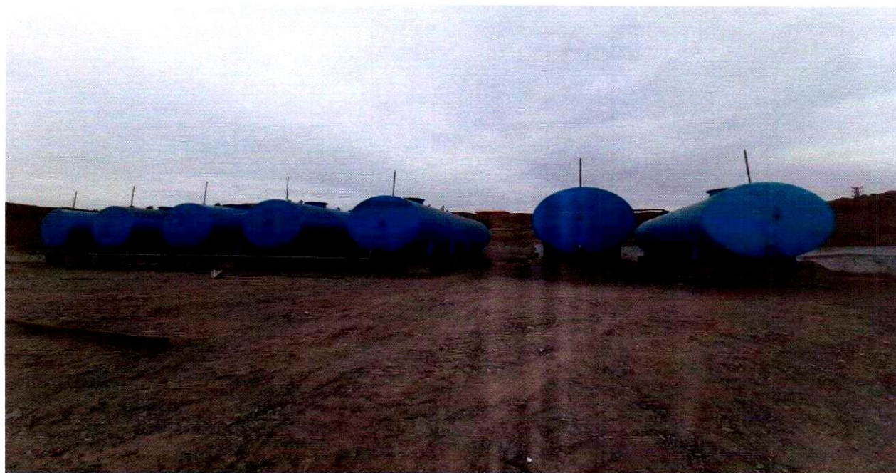
نصب تانک های سوخت و سیستم فیلتراسیون
